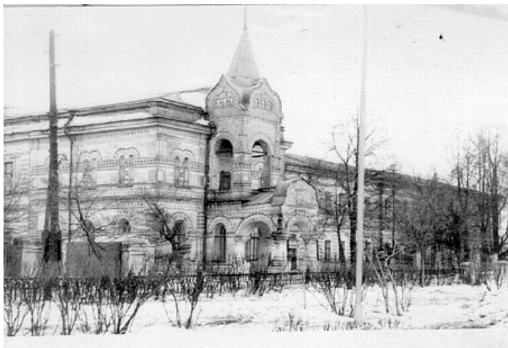
Здание училища слепых со встроенной Княже-Михайловской церковью ГАПО. Ф. 690. Оп.1. Д. 66.
