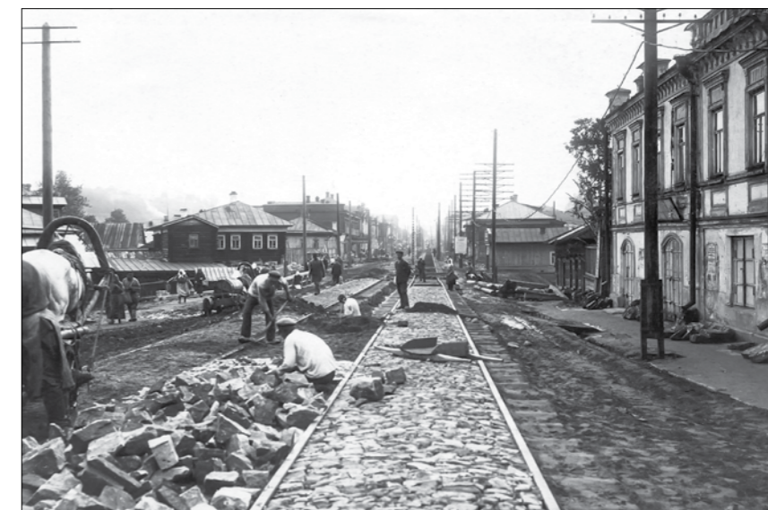
▶ Прокладка трамвайной линии и мощение улицы в Мотовилихе. Пермь, 1929 г.
